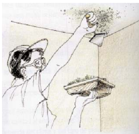
Fig. 5-14 Overhead ceiling plastering. Notice the use of goggles. (source: José de Jesús Saldaña Guerra, “MANOS A LA OBRA / MANUAL DE AUTOCOSTRUCIÓN”, Instituto Mexicano del Cemento y del Concreto - IMCYC, México, 1999)
