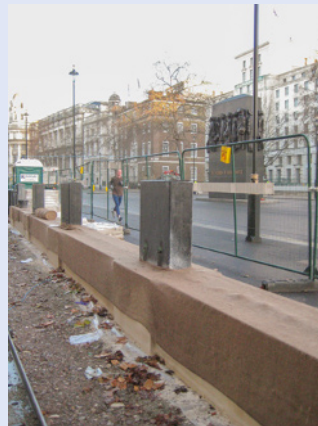
Abbildung 35: Einbau von Sicherheitsbarrieren zur Abwehr von Fahrzeugangriffen (Bild von Jon Coaffee)
