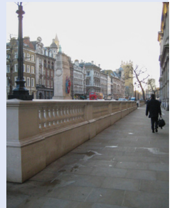
Abbildung 36: Fertiggestellte dekorative Balustraden zum Schutz vor Angriffen durch Fahrzeuge in Whitehall im Zentrum Londons (Bild von Jon Coaffee)
