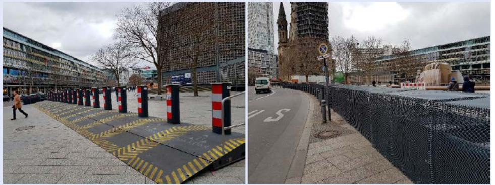
Abbildung 47: Breitscheidplatz mit Pollern und Schüttkörben gesichert (Bilder von Norbert Gebbeken)
