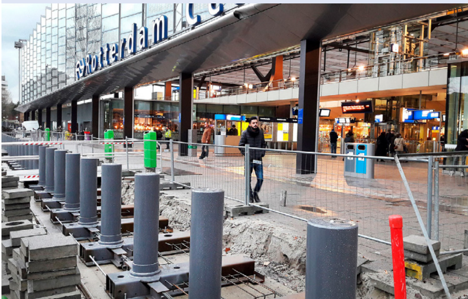
Abbildung 23: Platzierung der Barriere am Bahnhof Rotterdam Centraal (Bild von Ruijgrok/Stadt Rotterdam)
