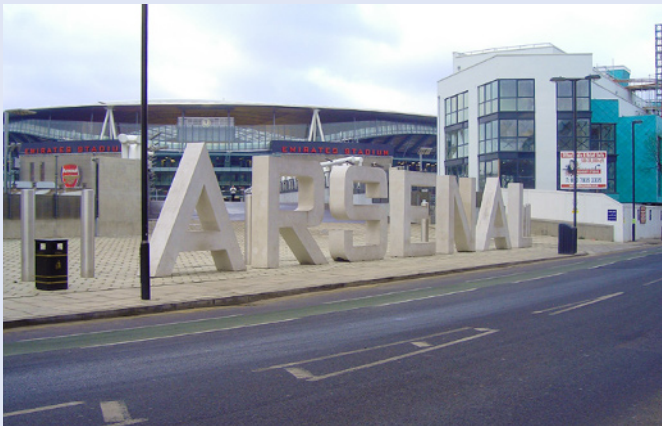
Abbildung 34: Eine Sicherheitsbarriere zur Abwehr von Fahrzeugangriffen im Emirates-Stadion im Norden Londons (Bild von Jon Coaffee)
