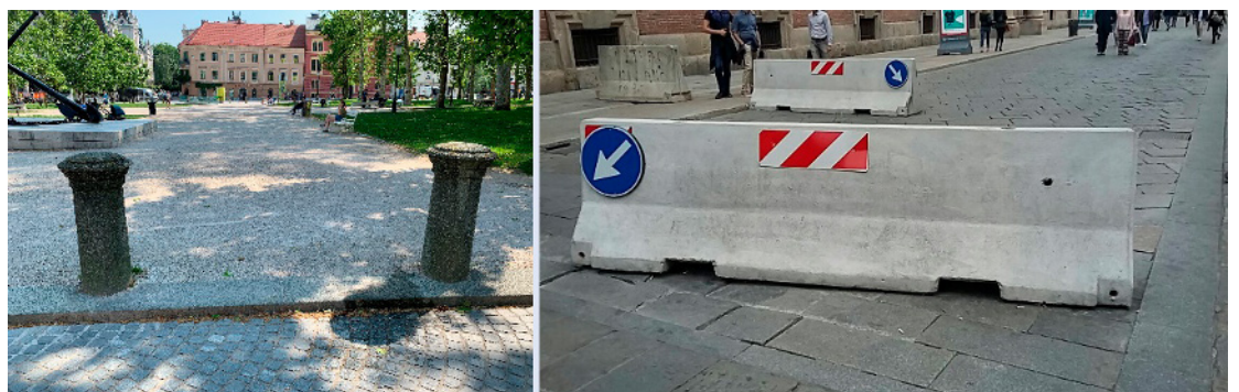
Abbildung 42: Beispiele für permanente (links) und temporäre Fahrzeugsicherheitsbarrieren (rechts) (Bilder von Vasilis Karlos)
