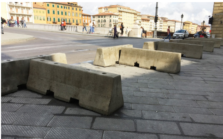
Abbildung 82: Betonblöcke als Schutzlösung (Bild von Vasilis Karlos)
