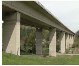
The Talübergang Warth bridge (Austria, 1980)
